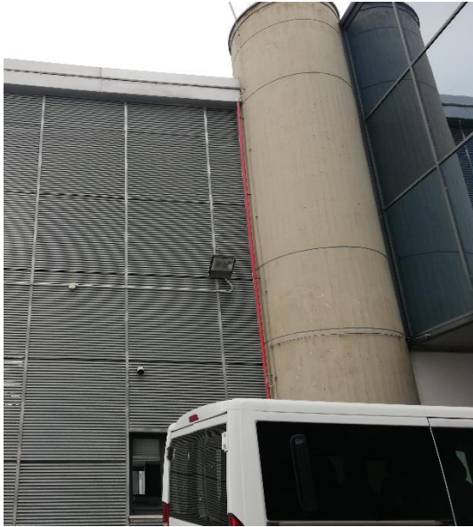
Figura 26 – Finto pilastro circolare
