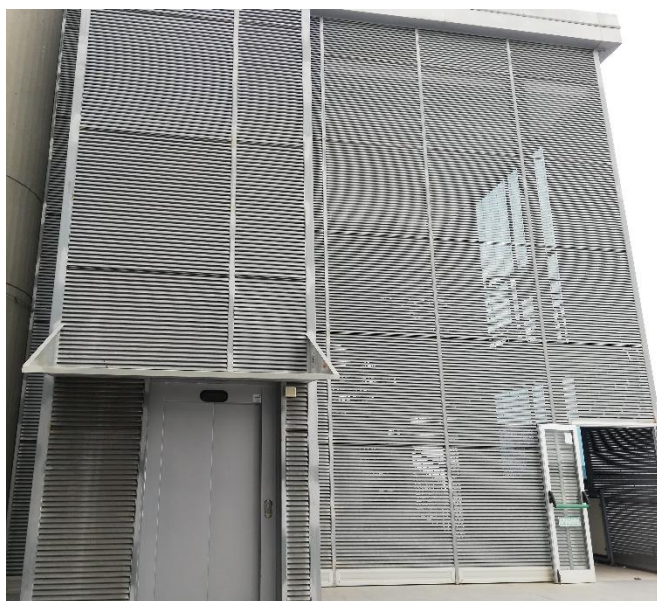
Figura 19 - Schermatura solare - vista esterna
