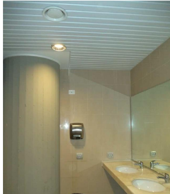
Figura 39 - lampada fluorescente 2x26 W
