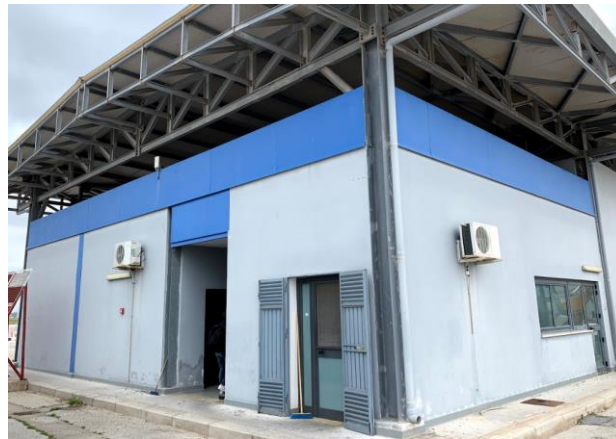
Figura 47 – edificio "Ricovero mezzi di rampa"
