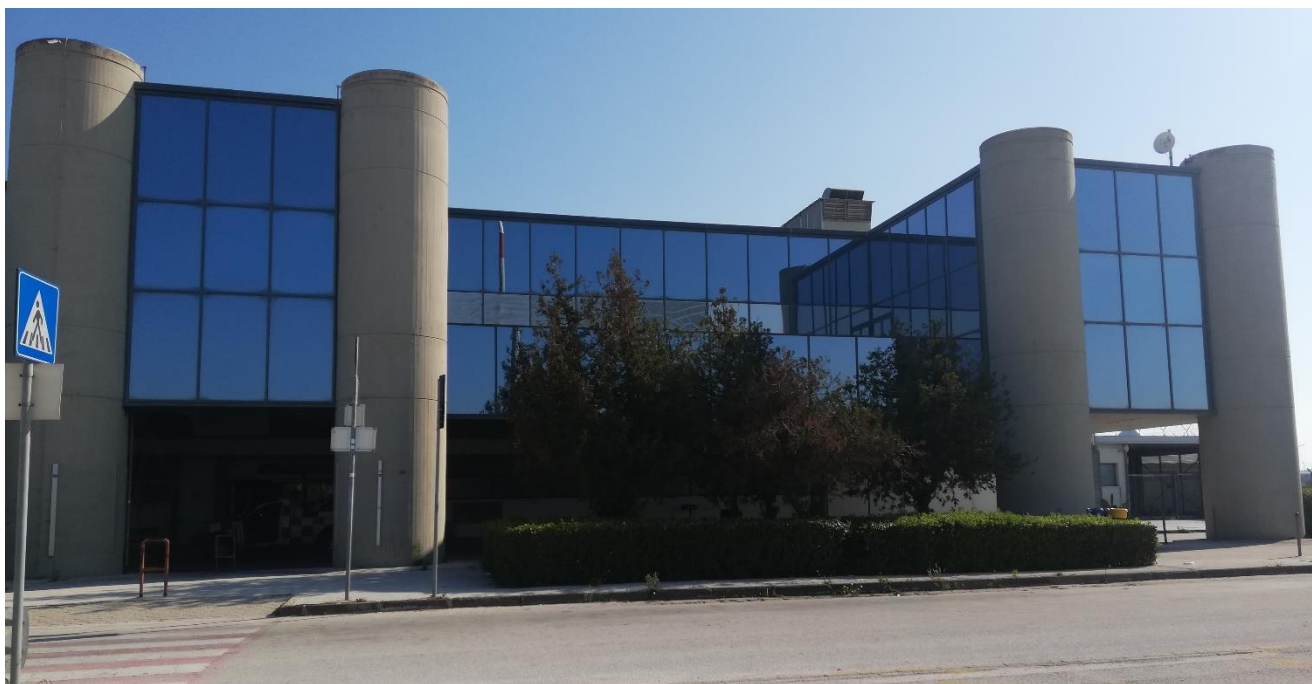
Figura 18 - Terminal passeggeri e Uffici
