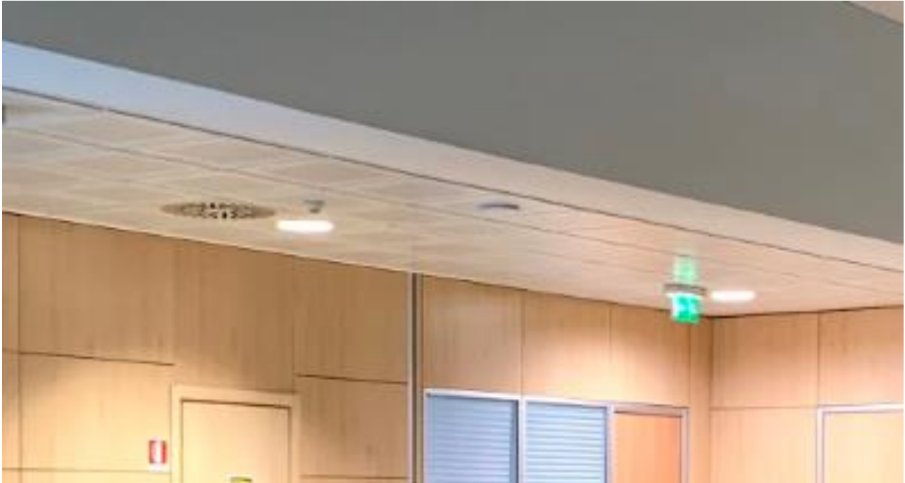
Figura 76 - Differenza di ampiezza ed intensità luminosa tra un faro LED (a destra) ed un faro a fluorescenza (a sinistra) installati presso il Terminal dell'Aeroporto di Trapani Birgi
