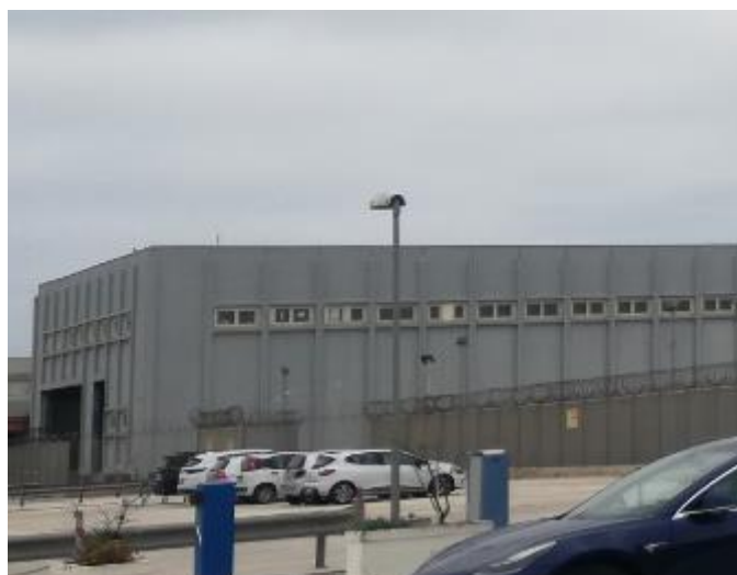
Figura 50 – edificio "Locali merci"
